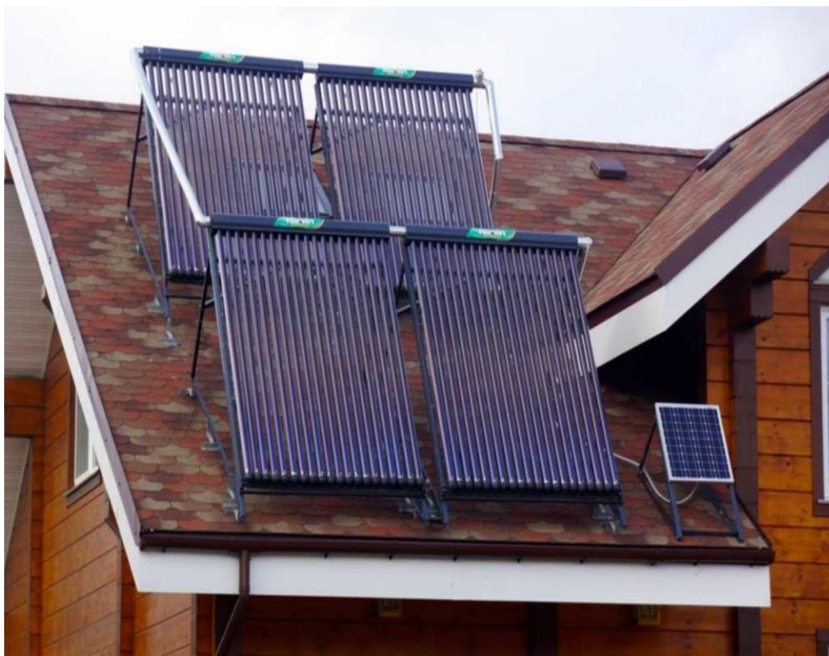
1.5- сурет - Вакуумдық күн коллекторлары. Орнату құрылымы шатырлы жабында
