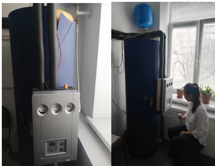
2.1- сурет - Қазақстан-Неміс Университетінде орнатылған күн коллекторларымен жылыту және ЫСЖ жүйесіндегі бак-аккумулятор
